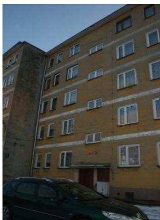
Rys. nr 1. Fragm. elew frontowej.
