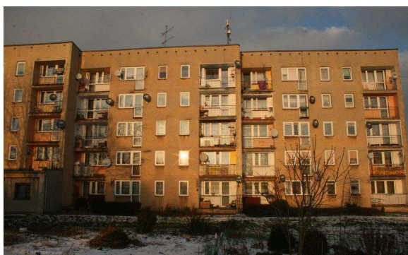
Rys. nr 4. Elewacja loggiowa SW.
