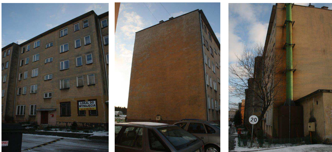
Rys. nr 1,2,3 Elewacja frontowa NE oraz elewacje szczytowe NW i SE.
