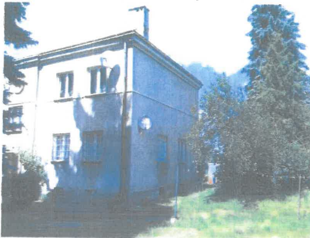
Fot. 1: Elewacja wschodnia – budynek mieszkalno - usługowy
