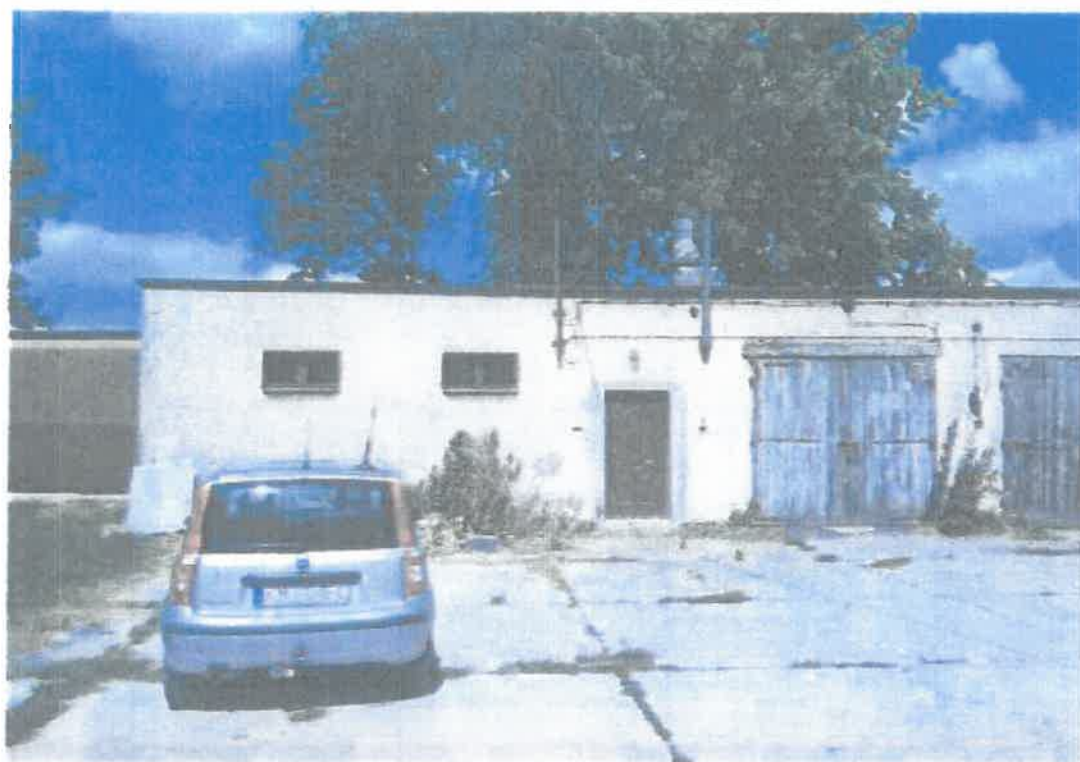
Fot. 5: Elewacja południowa – budynek mieszkalno - gospodarczy
