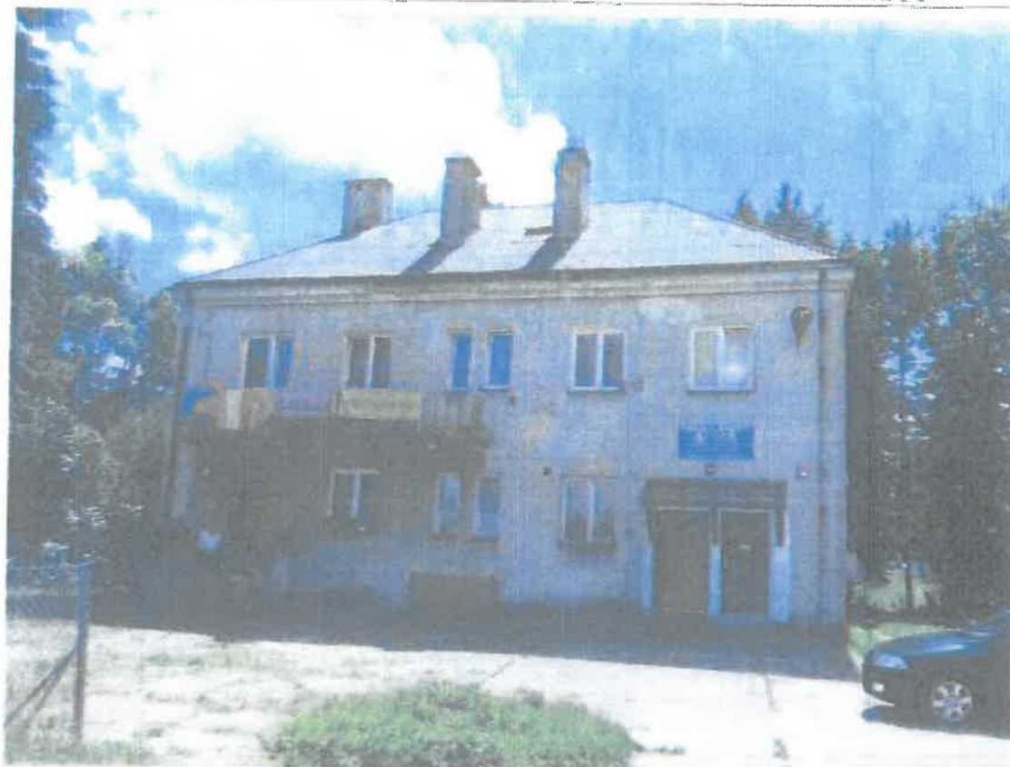
Fot. 3: Elewacja północna – budynek mieszkalno - usługowy
