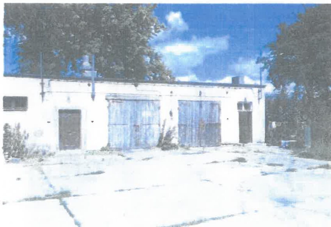
Fot. 6: Elewacja południowa – budynek mieszkalno - gospodarczy
