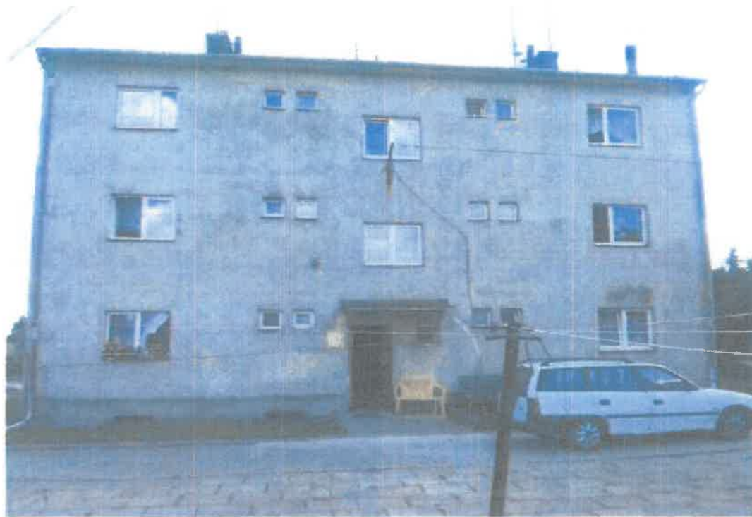
Fot. 1: Elewacja wschodnia
