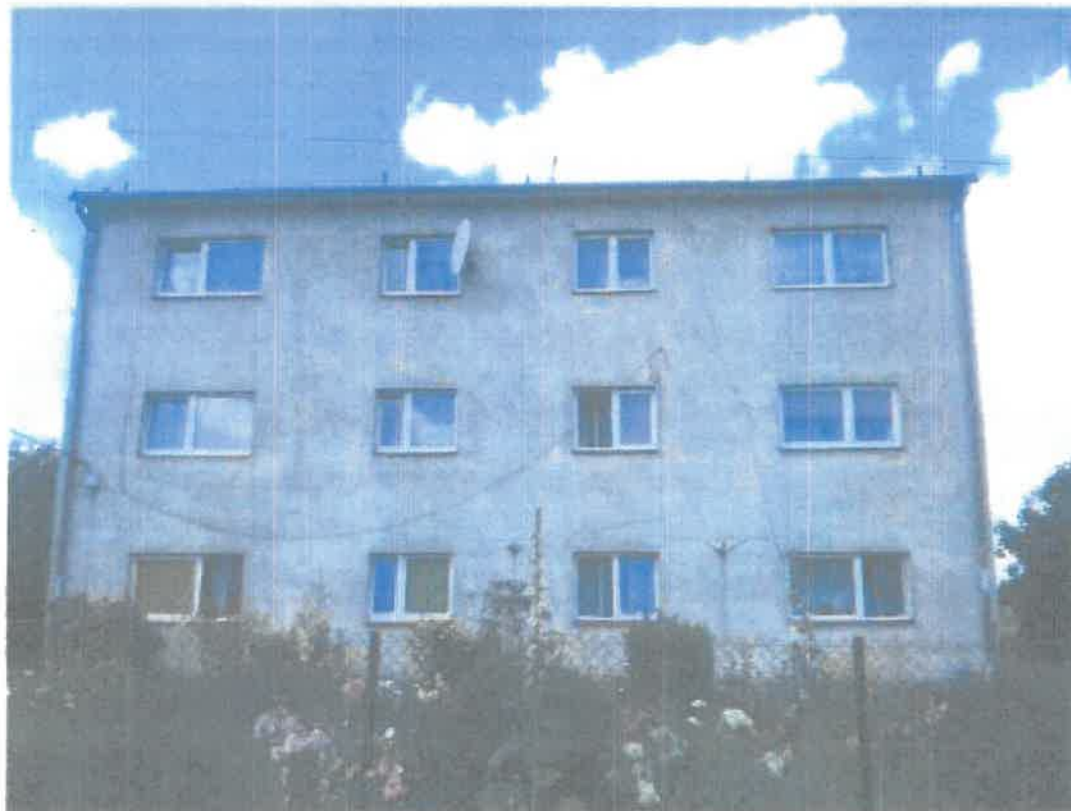
Fot. 2: Elewacja zachodnia
