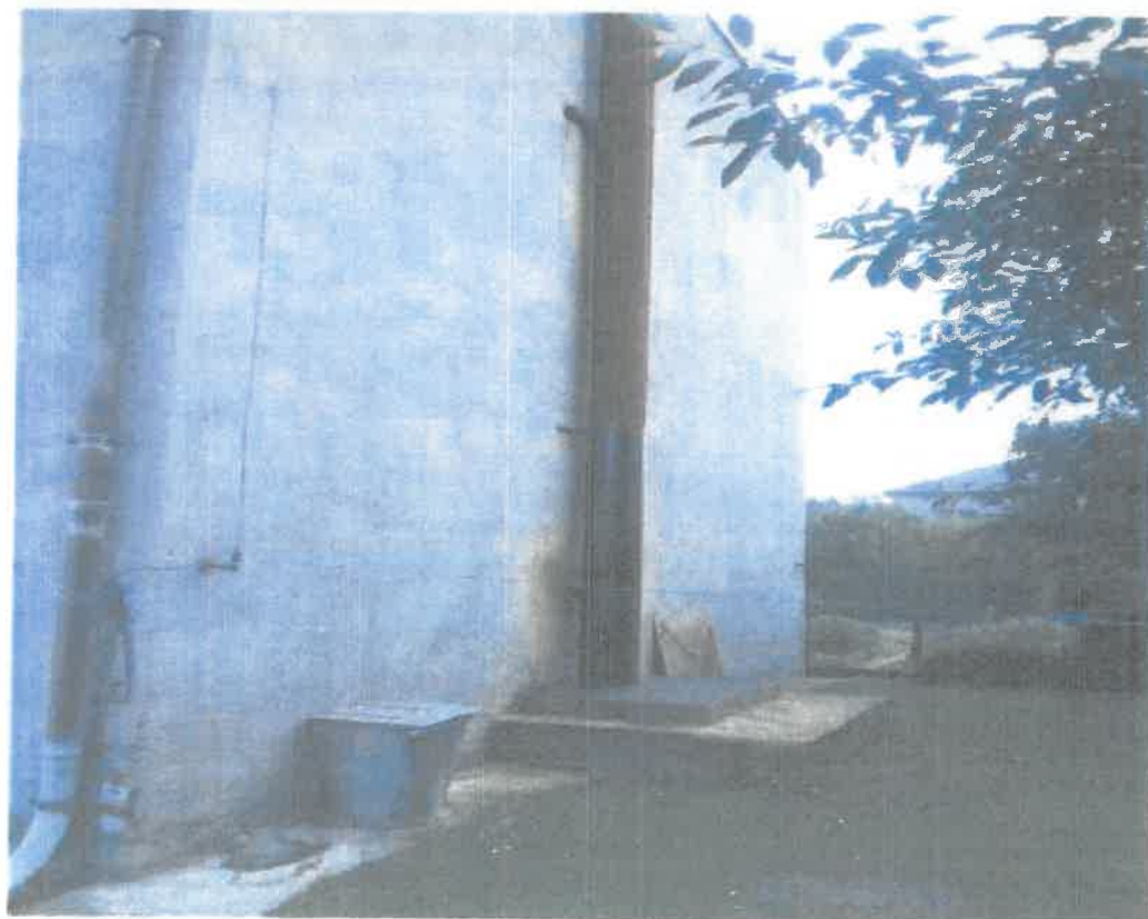
Fot. 4: Elewacja południowa
