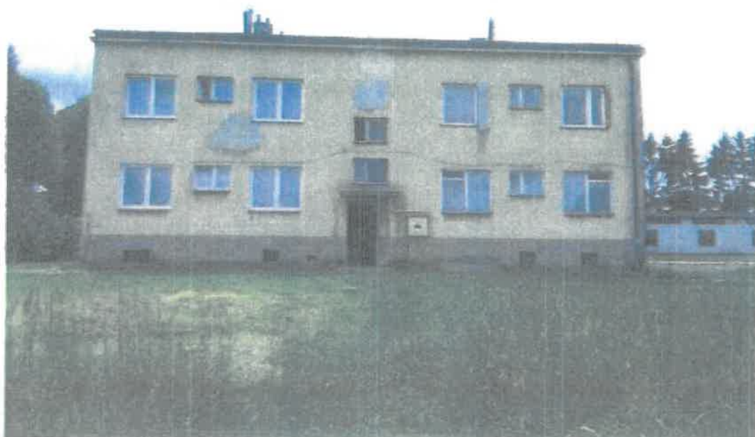
Fot. 3: Elewacja północna
