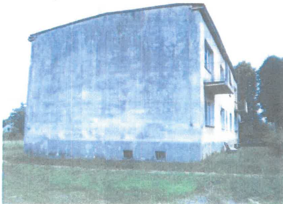
Fot. 2: Elewacja zachodnia
