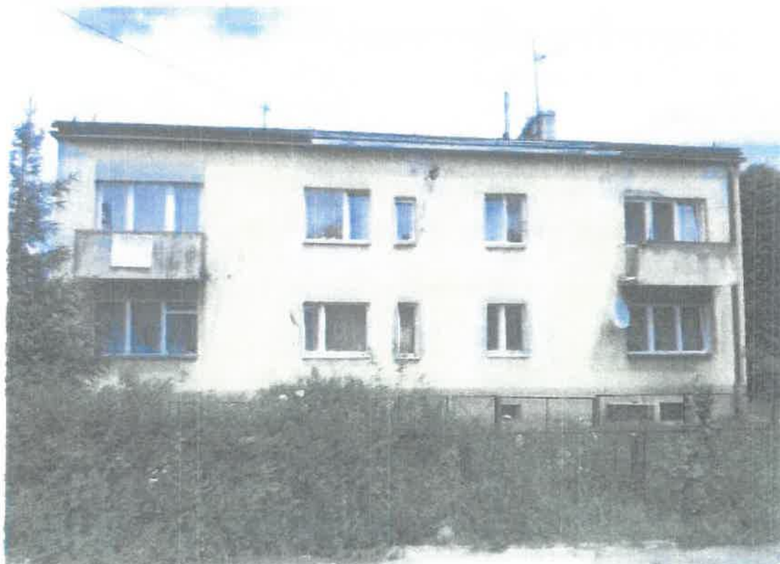
Fot. 4: Elewacja południowa
