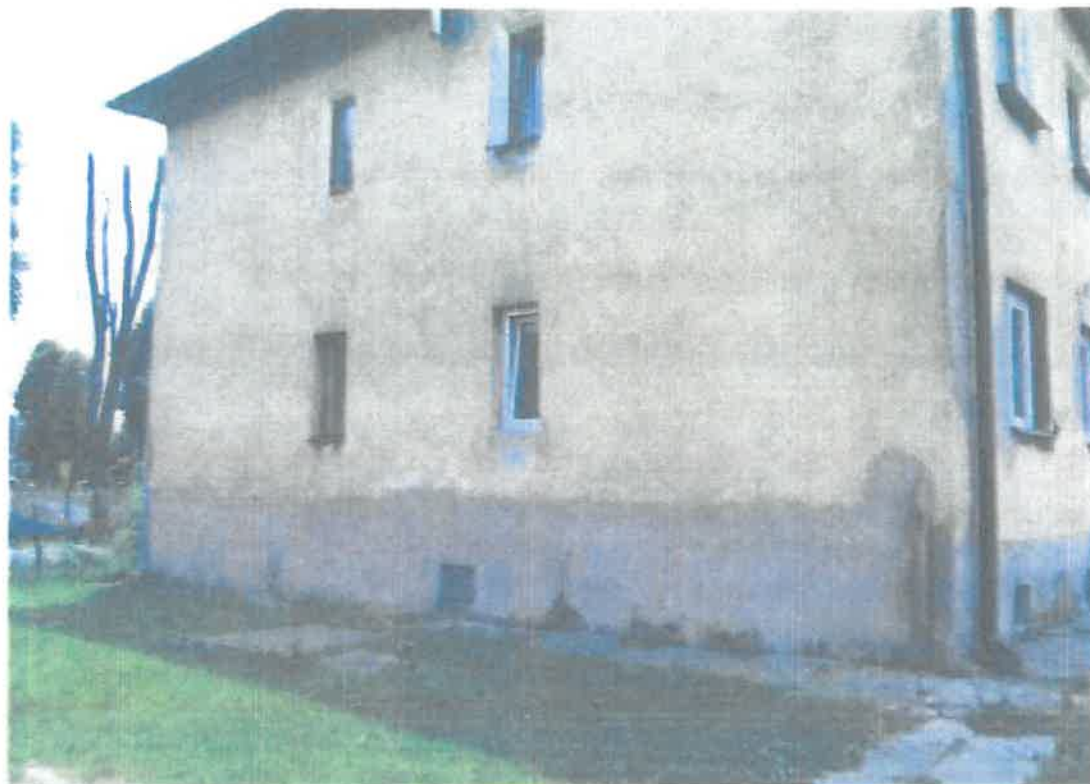
Fot. 1: Elewacja wschodnia
