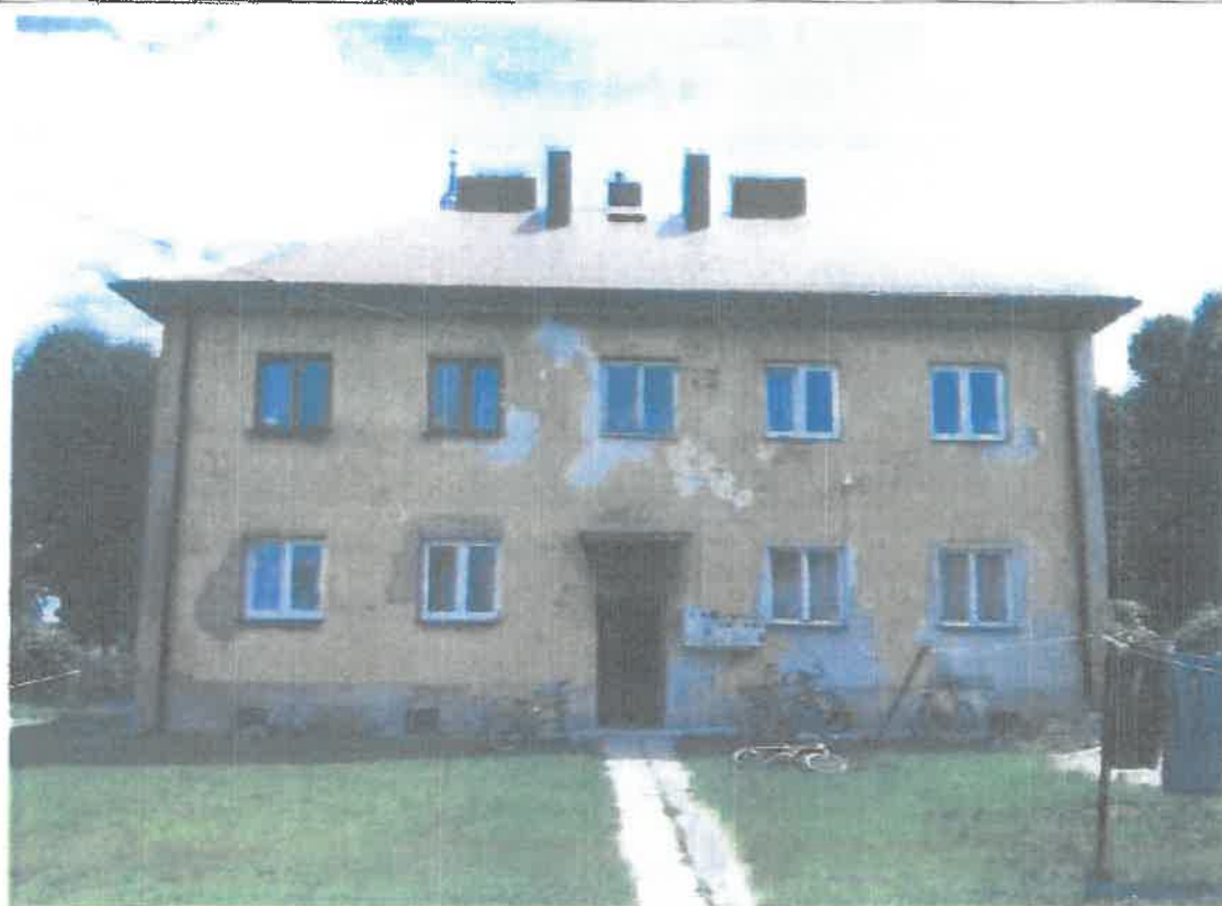
Fot. 3: Elewacja północna
