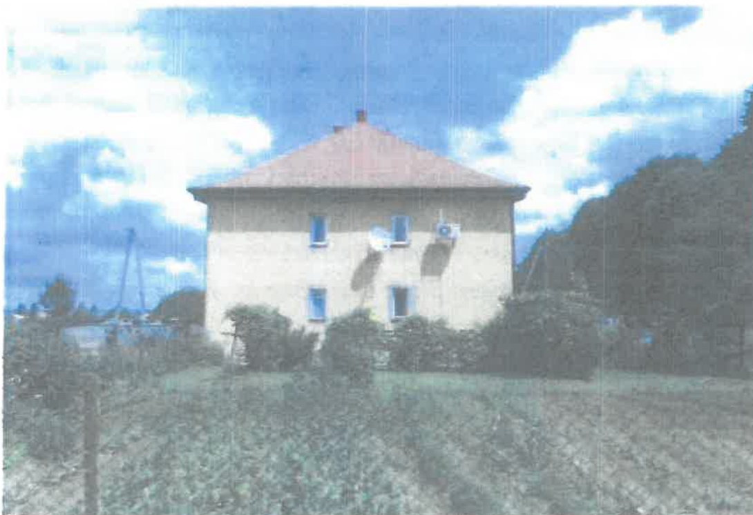
Fot. 2: Elewacja zachodnia
