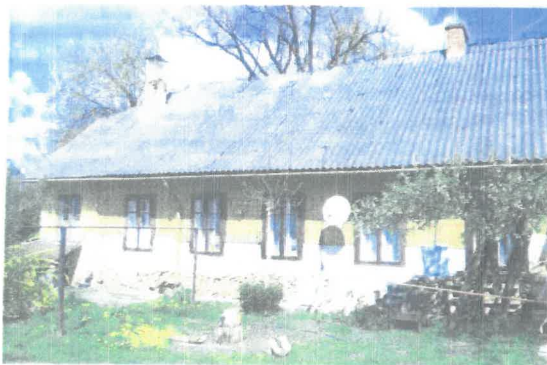
Fot. 4: Elewacja południowa
