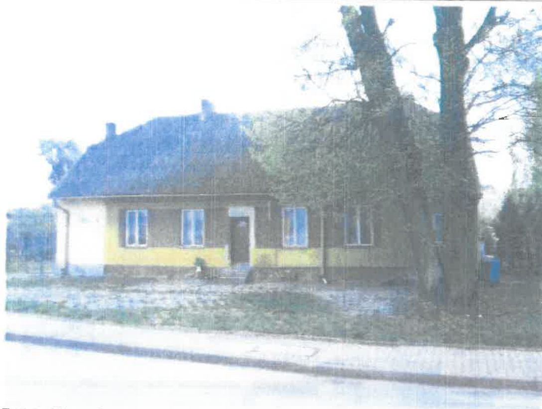
Fot. 3: Elewacja północna
