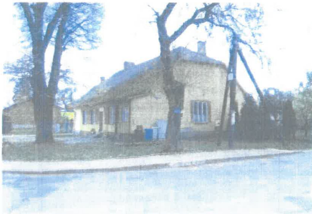
Fot. 2: Elewacja zachodnia
