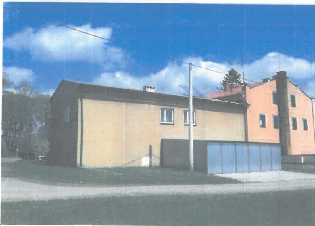
Fot. 4: Elewacja południowa
