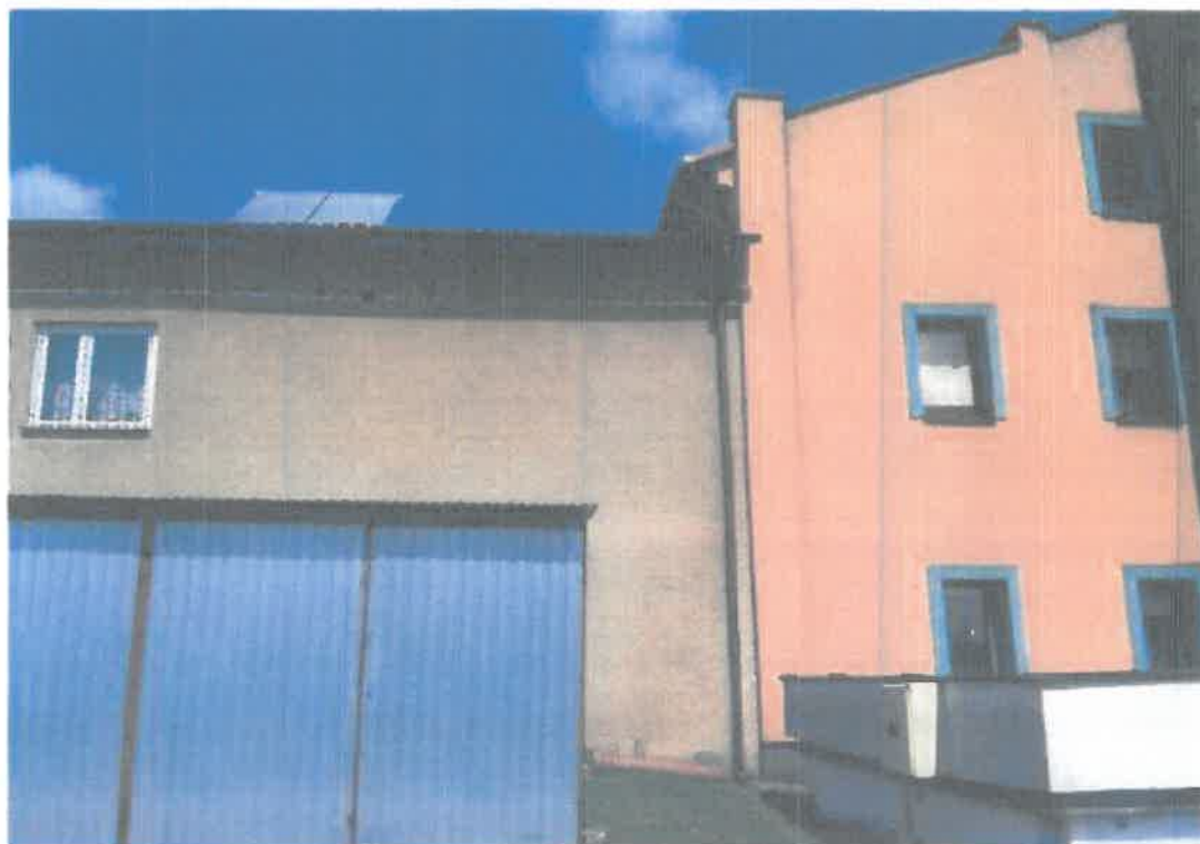
Fot. 1: Elewacja wschodnia
