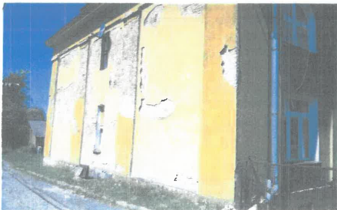
Fot. 4: Elewacja południowa
