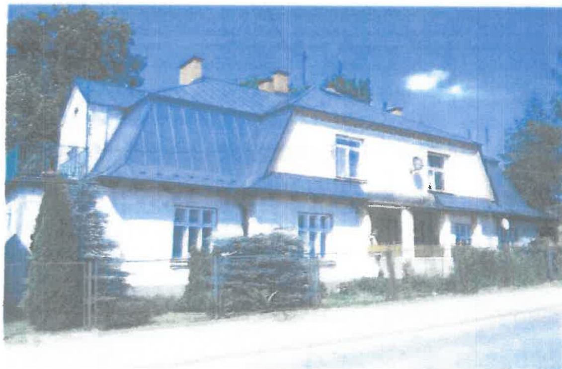
Fot. 4: Elewacja południowa
