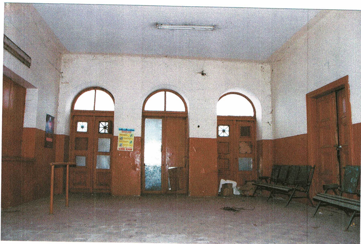
Fot.7. Dworzec Kolejowy w Charsznicy z1885 r. Stan zachowania przed konserwacją Hol główny dworca. Widok ogólny. Luty 2017 r. Fot. Tadeusz Sokal
