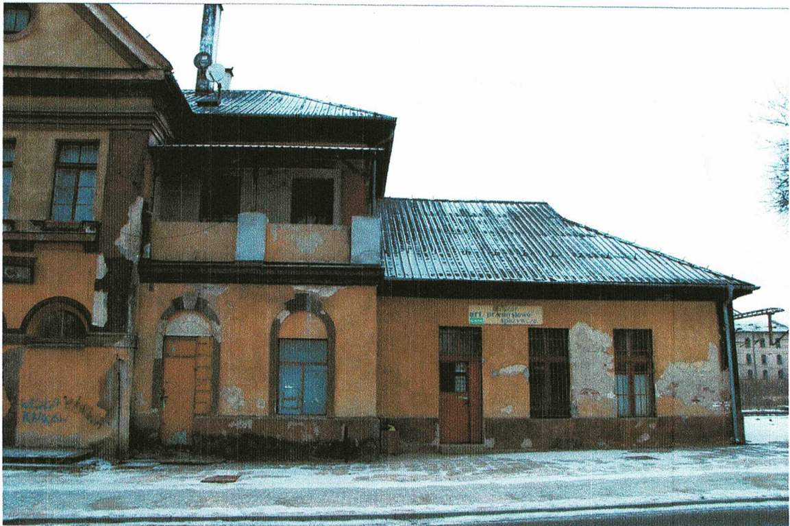
Fot.3. Dworzec Kolejowy w Charsznicy z1885 r. Stan zachowania przed konserwacją Elewacja wschodnia od strony ul. Kolejowej. Widok części budynku po prawej stronie, zawilgocenia, ubytki tynku, wstawione drzwi. Luty 2017 r. Fot. Tadeusz Sokal
