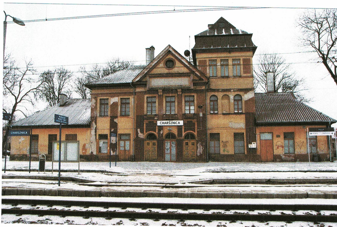
Fot.2. Dworzec Kolejowy w Charsznicy z1885 r. Stan zachowania przed konserwacją Elewacja zachodnia od strony peronu. Widok ogólny. Luty 2014 r. Fot. Tadeusz Sokal
