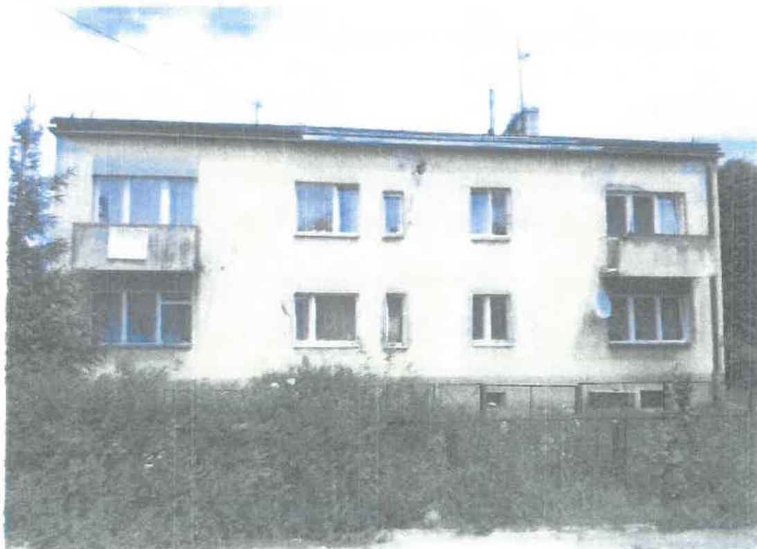
Fot. 4: Elewacja południowa
