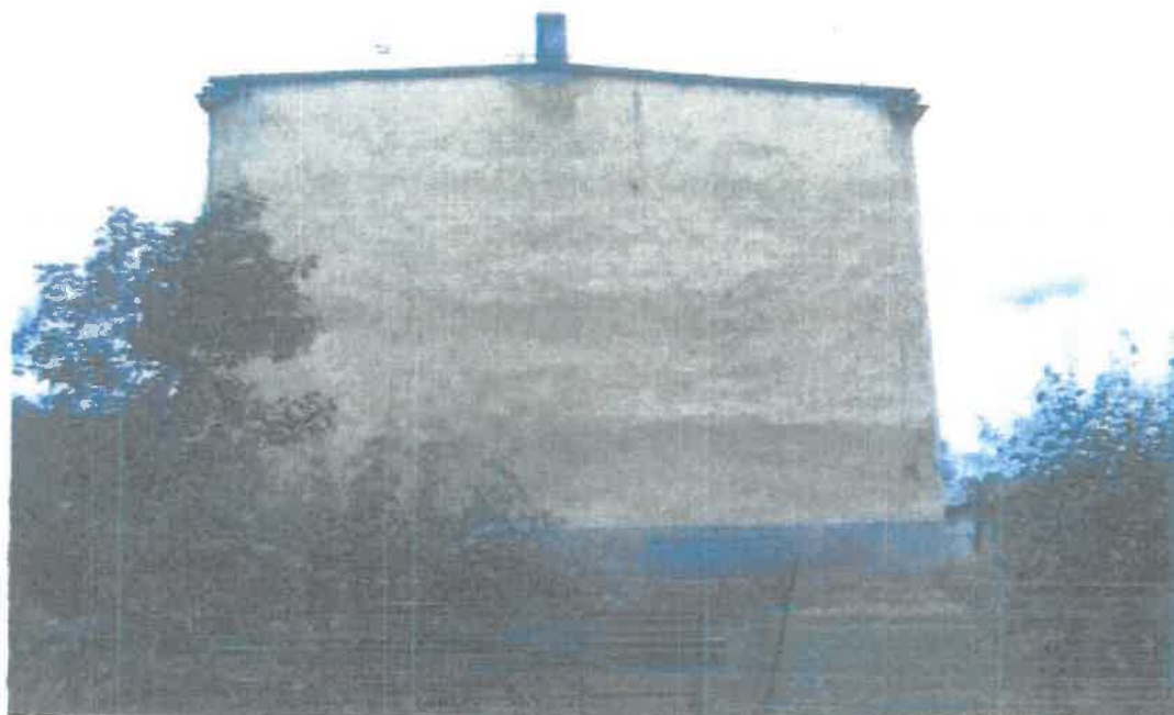
Fot. 1: Elewacja wschodnia
