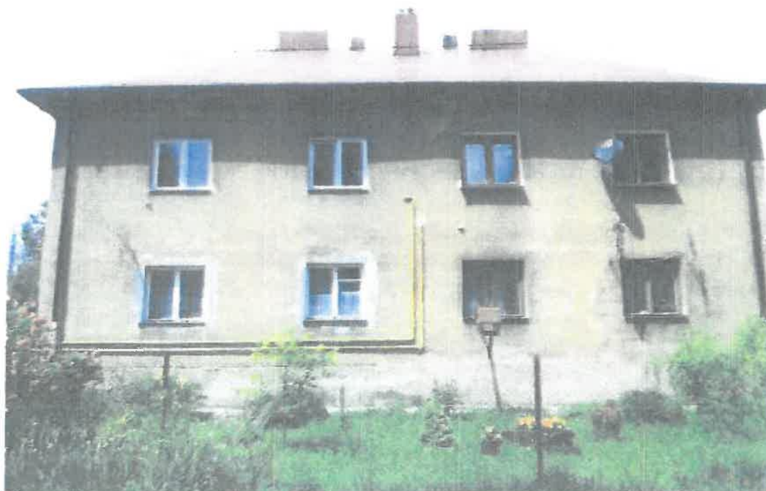
Fot. 4: Elewacja południowa
