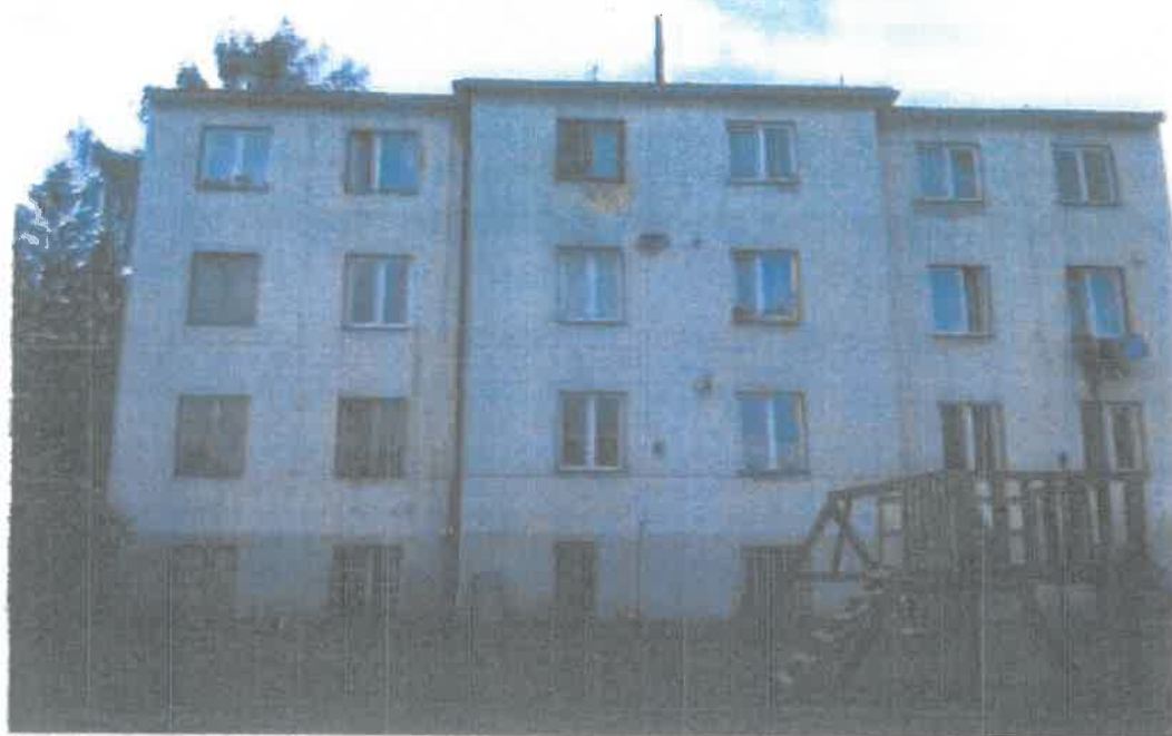
Fot. 3: Elewacja północna
