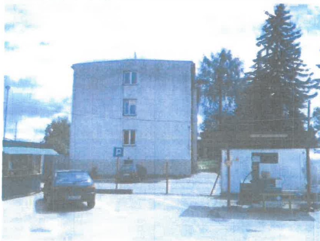
Fot. 2: Elewacja zachodnia
