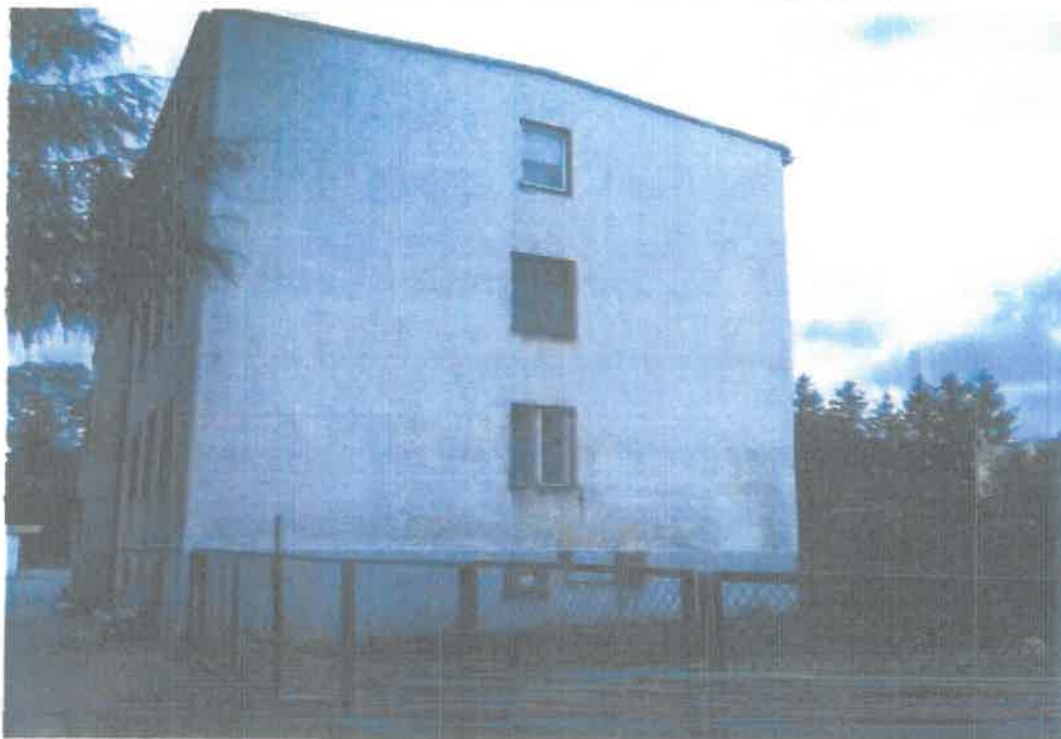
Fot. 1: Elewacja wschodnia
