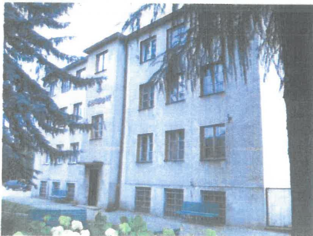
Fot. 4: Elewacja południowa
