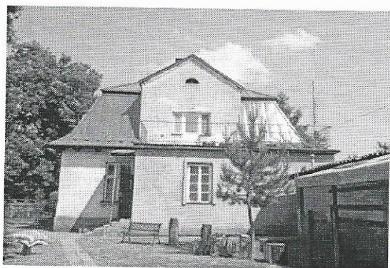
Widok - elewacja wschodnia
