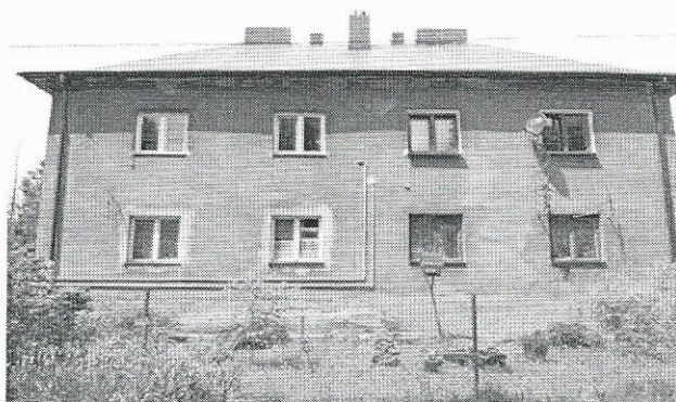
Widok - elewacja południowa
