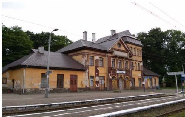
Widok - elewacja północna
