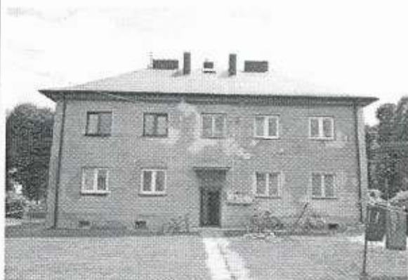
Widok - elewacja północna
