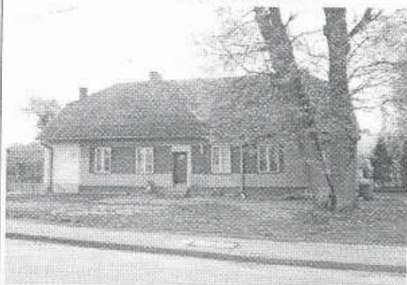
Widok - elewacja północna
