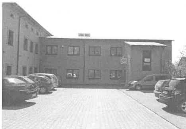
Widok - elewacja północna
